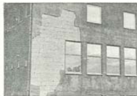
Fig. 9.24. Nedfald af tykt lag af stærkt puds på porebeton.
