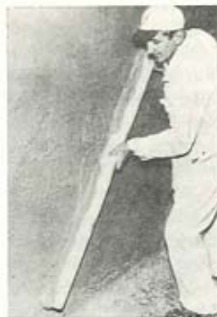
Fig. 9.22. Udjævning af indvendigt tyndpuds med langt retholt.
