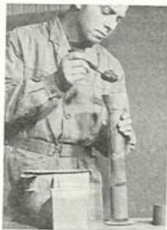
Fig. 12.01. Bestemmelse af frisk mørtels luftindhold.
