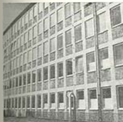
Fig. 9.25. Pudslager adskilte af bånd.
