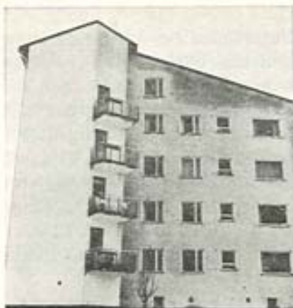
Fig. 9.30. Fugtmatte pudse ud for kolde loftrum.
