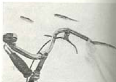
Fig. 13.09. Mekanisk skadet puds.
