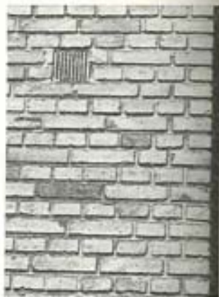
Fig. 13.22. Blank mur af gul teglsten med uens patinering.
