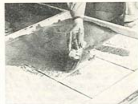
Fig. 15.12. Der kastes tyndgrundingsmørtel ud på bagsiden af keramiske fliser i bunden af form til støbte facadeelementer.
