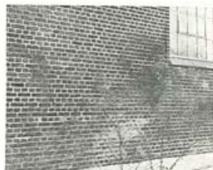
Fig. 13.21. Misfarvende salte ført frem med fugtighed indefra (mejeri).
