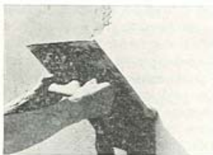
Fig. 9.21. Påtrækning af sidste lag til ædeltyndpuds.
