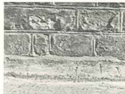
Fig. 13.24. Teglstensskifter langs for-tov. Snavs har tætnet stenenes brand-hud, og krystaller bagved har løsnet den.
