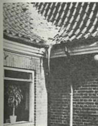
Fig. 13.01. Årsag og virkning: Spærring af tagrenden ved revnet gesims har ført til omfattende indvendig fugtskade.
