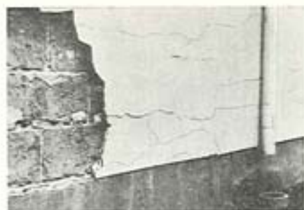
Fig. 13.13. For tæt pudslag fraspærngt af is langs bagsiden.
