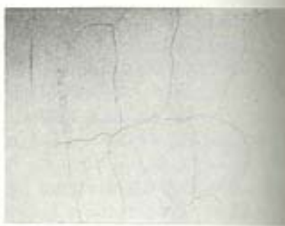
Fig. 13.15. Grovmasket net af svindrevner i puds.
