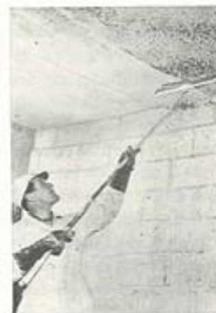
Fig. 9.23. Udjævning af tyndpuds på loft med gummispartel på skaft.
