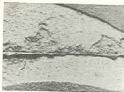
Fig. 9.36. Skadet puds over vandret paplag.
