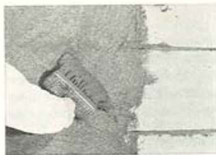
Fig. 9.11. Tyndgrundning ved kostning.
