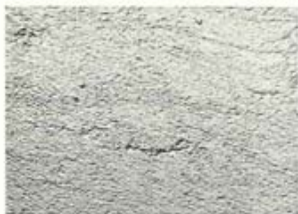
Fig. 9.18. Skridningsrevner i frisk grovpuds.
