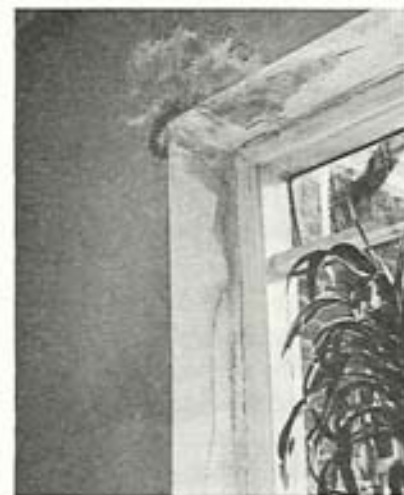
Fig. 13.01. Årsag og virkning: Spærring af tagrenden ved revnet gesims har ført til omfattende indvendig fugtskade.
