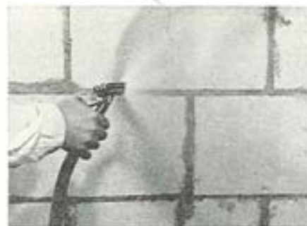
Fig. 9.07. Underlaget vandes fra slange med spreder.
