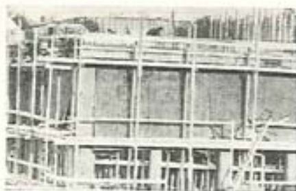
Fig. 10.04. Nyt murværk tildækket med presenning.
